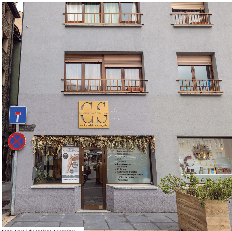
Fons: Comú d'Escaldes-Engordany. Cal Ton del Quim. Any 2025.
