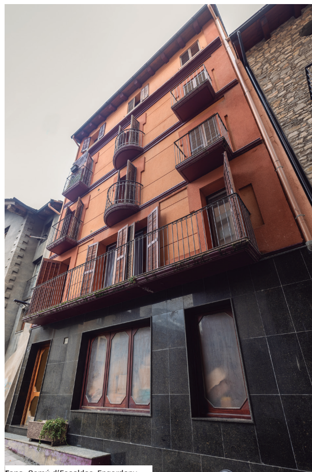
Fons: Comú d'Escaldes-Engordany. Cal Quelo. Any 2025.
